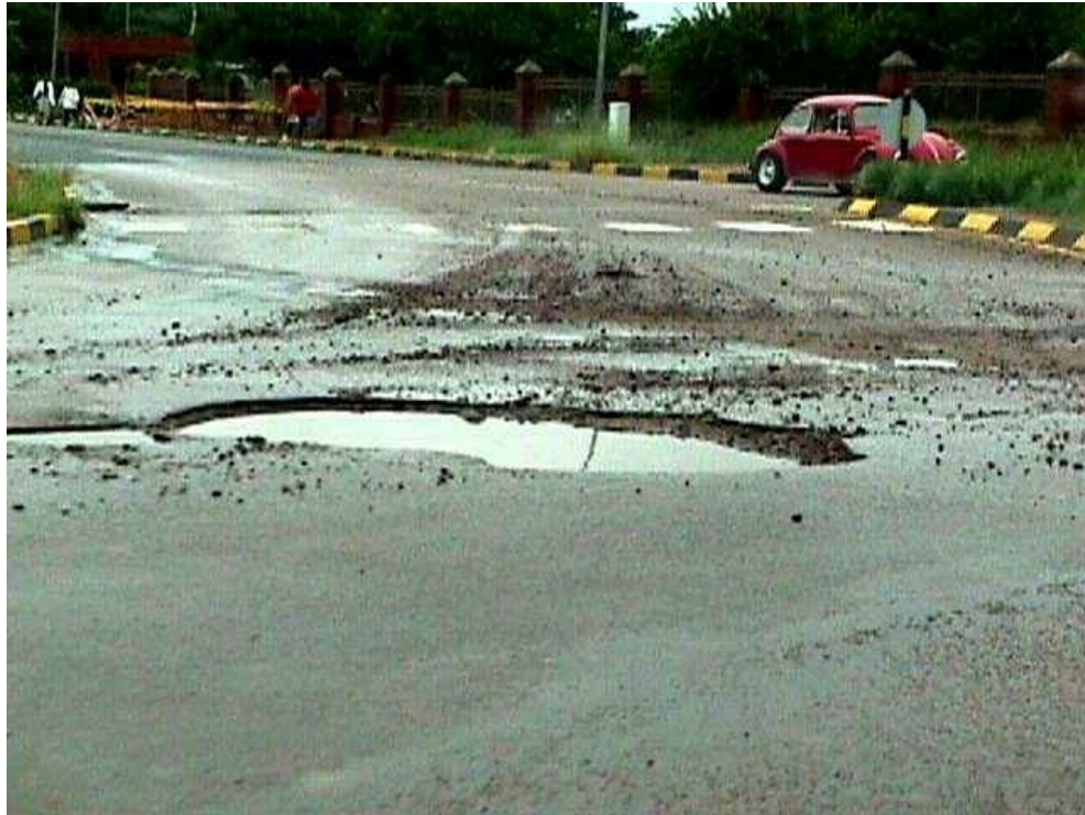
Typische Straßenschäden (Foto I. Kittmann)
