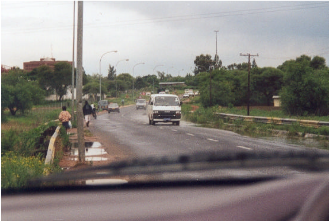
Schulweg in Gaborone: Die Brücke führt über einen Wasserlauf und hat keine befestigten Gehwege. Bei Regen müssen Fußgänger die Fahrbahn benutzen
