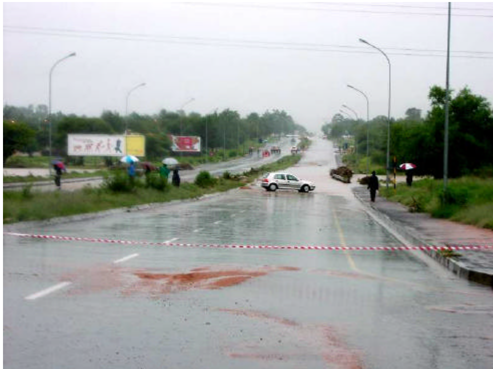
Temporäre Überschwemmung einer ca. 1999 gebauten Straße in Gaborone
