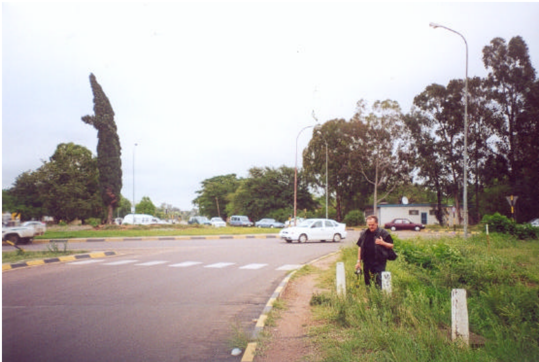
Kreisverkehrs in Gaborone mit Querungshilfen für Fußgänger, jedoch ohne weiterführende Gehwege
