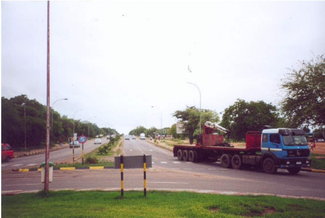
Typische Hauptverkehrsstraße in Gaborone mit unzureichend ausgebauten Seitenstreifen und Trampelpfaden auf dem Mittelstreifen
