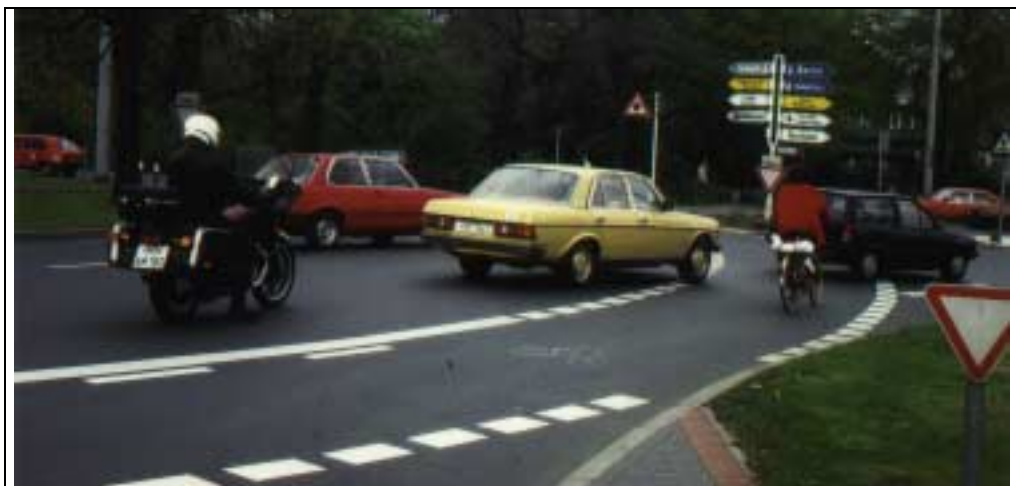
Abb. 2 Bei zweistreifigen Kreisverkehrsplätzen treten oft Sichtbehinderungen zwischen Radfahrern und auf dem inneren bzw. linken Fahrstreifen fahrenden Kraftfahrern auf (Hannover)
