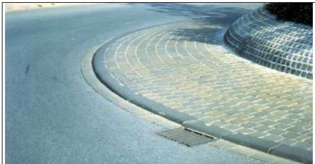
Abb. 11: Kreisverkehrsplatz mit baulich abgesetztem Innenring
